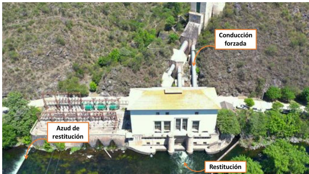
Figura 14. Componentes del Sistema Hidroeléctrico Cassaffousth
